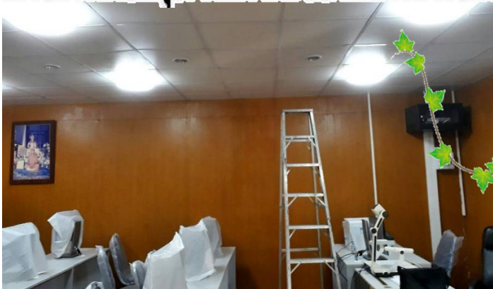
โครงการปรับปรุงซ่อมแซมระบบไฟฟ้าในโรงเรียน
