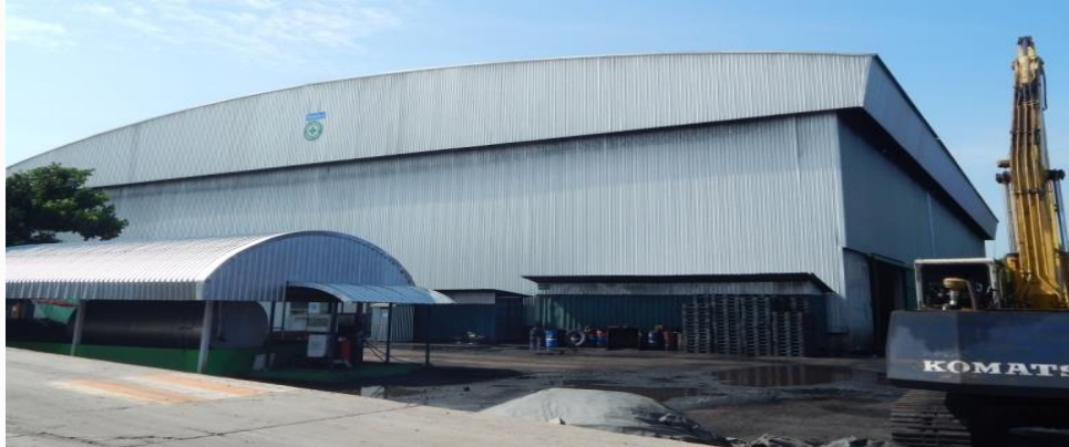
การสร้างอาคารคลุมเครื่องจักร ป้องกันเสียงและฝุ่นละอองสู่ภายนอก
