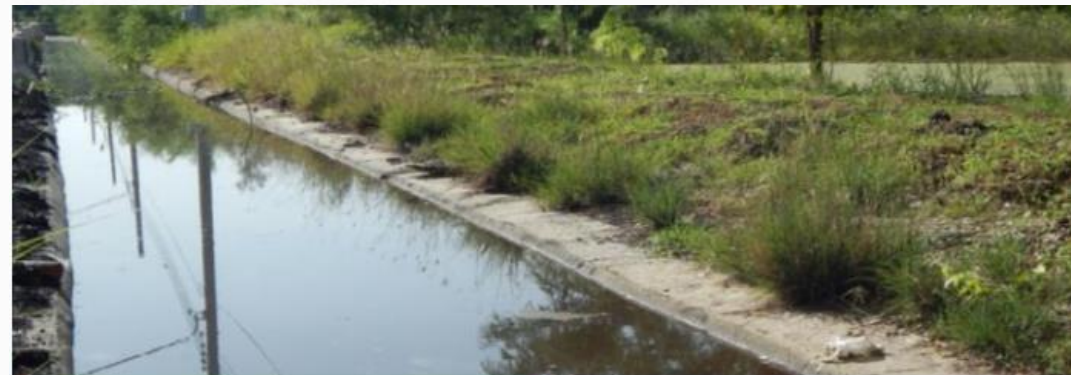
ระบบระบายน้ำรอบโรงงาน
